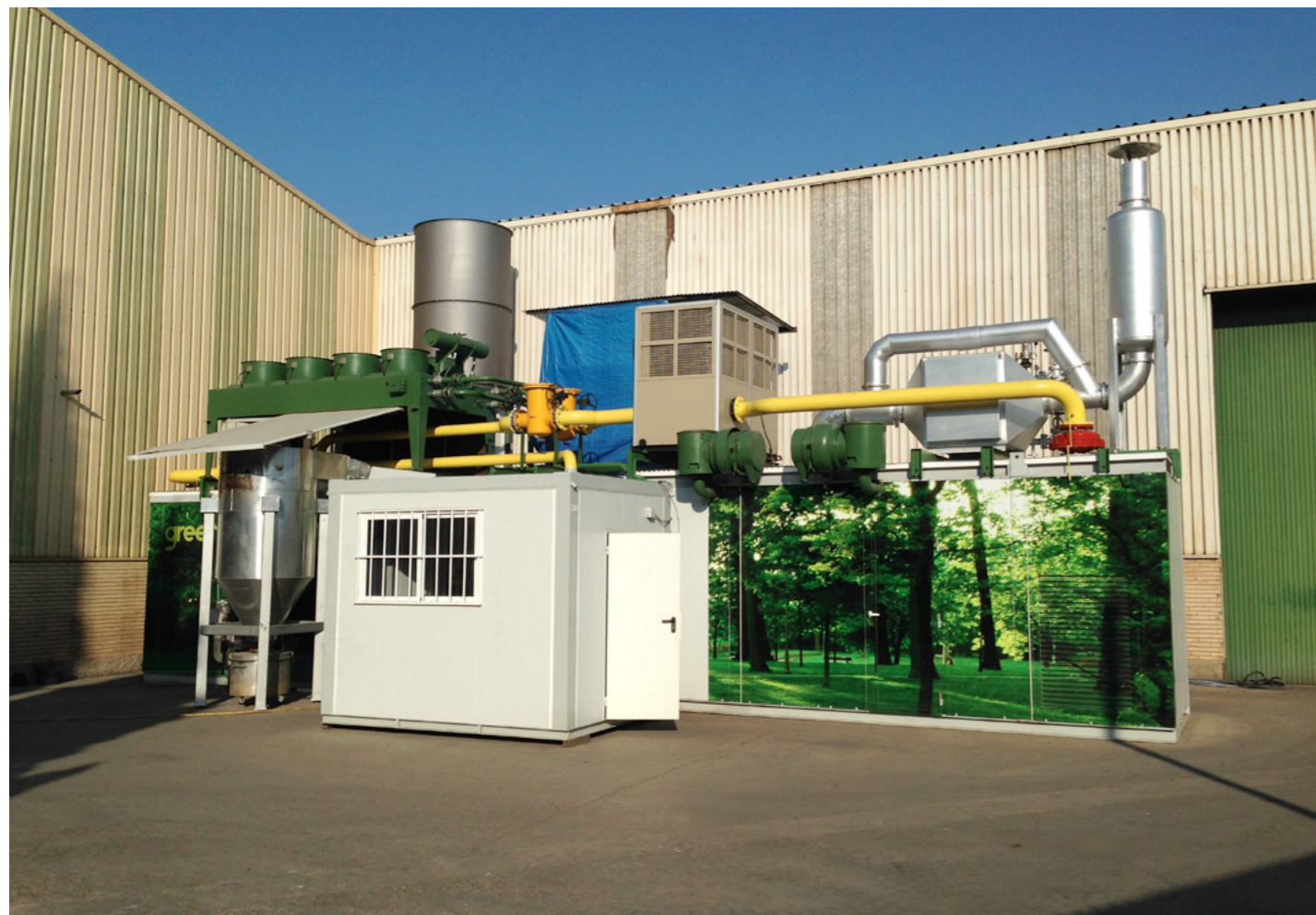
Módulo de gasificación.
