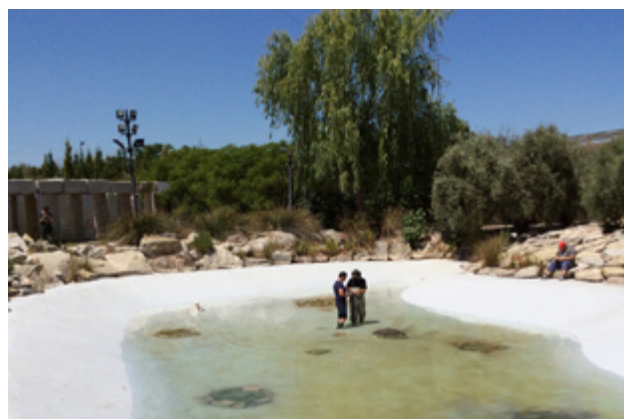
Colocación de las isletas de insolación en el estanque
