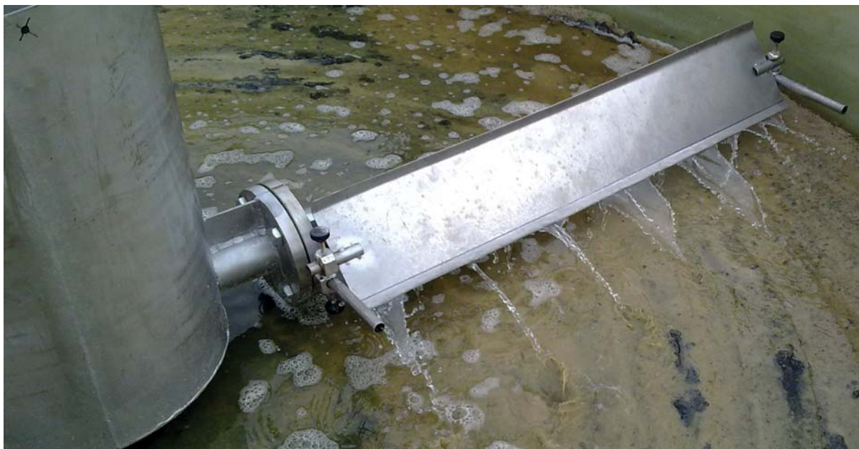
Distribución de agua en el sistema de Filtración-Percolación modificada
