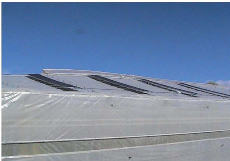
Placas solares sobre invernaderos de raspa y amagado con cubierta plástica difusa
